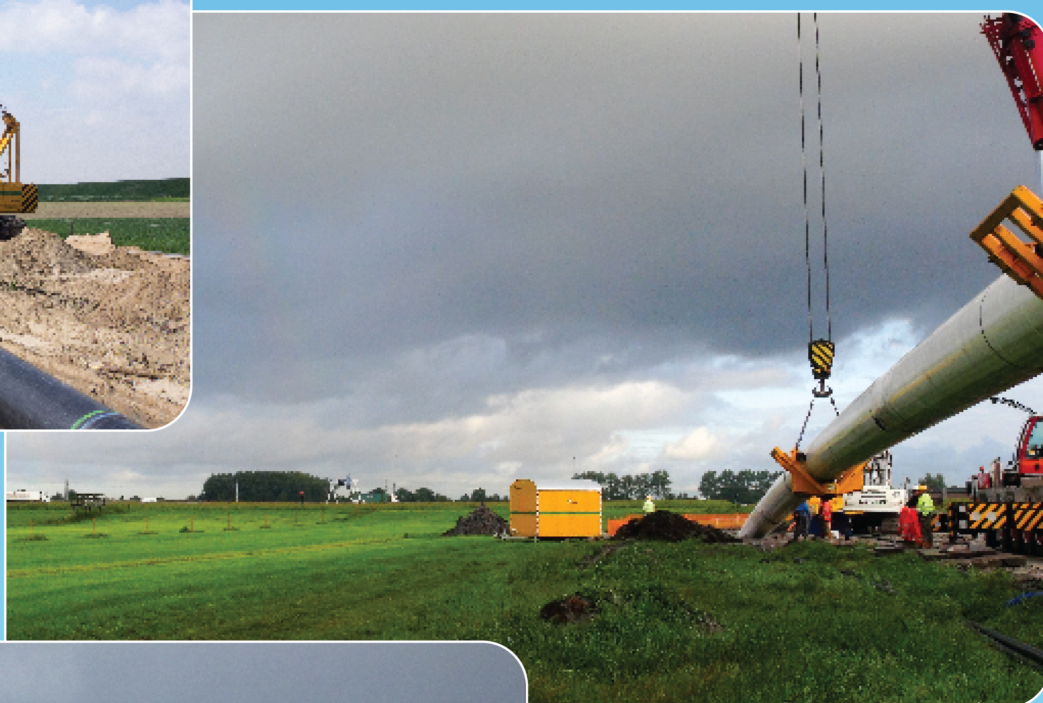
Aanleg leiding met horizontaal gestuurde boring
