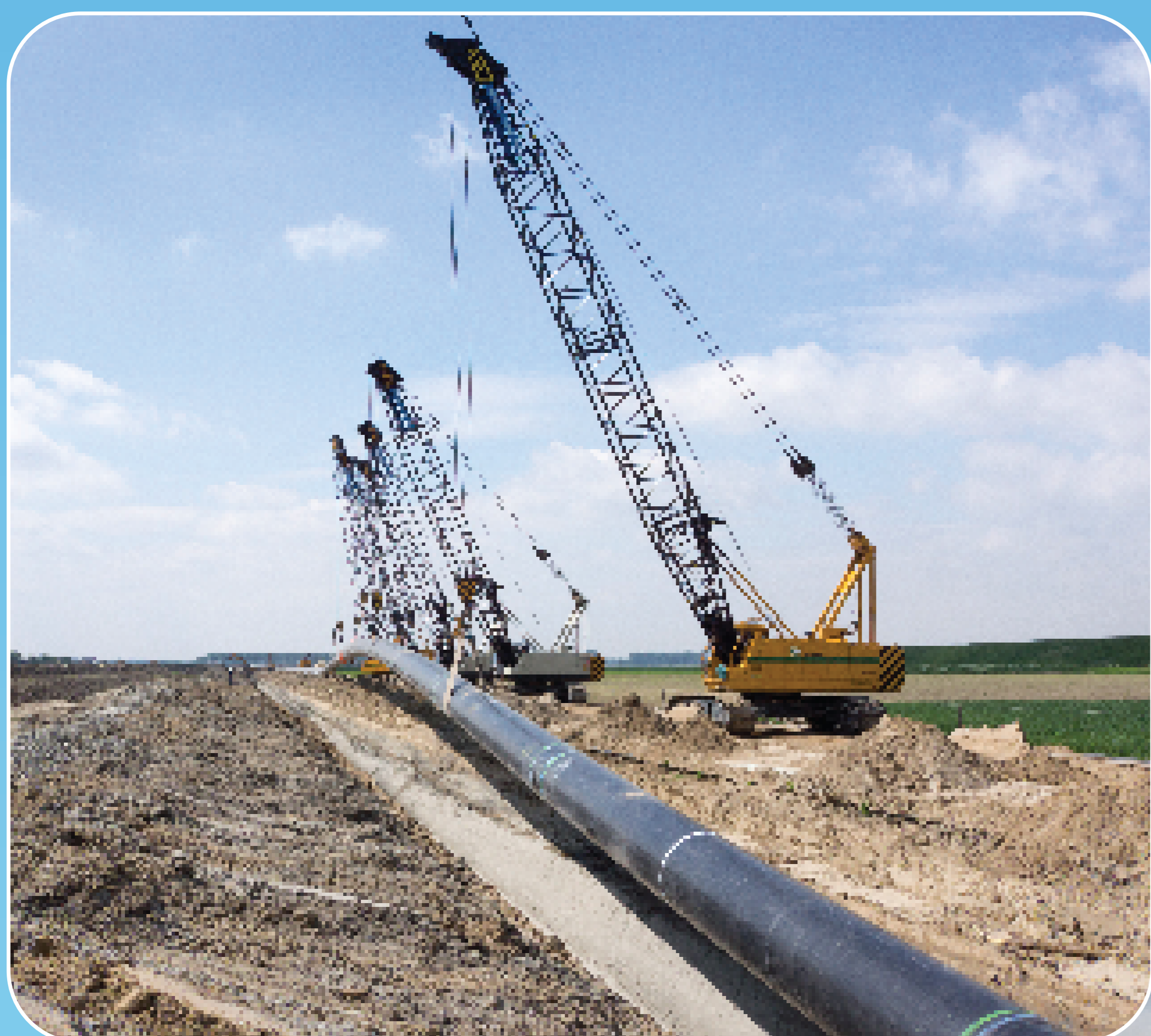
Aanleg leiding met open ontgraving
